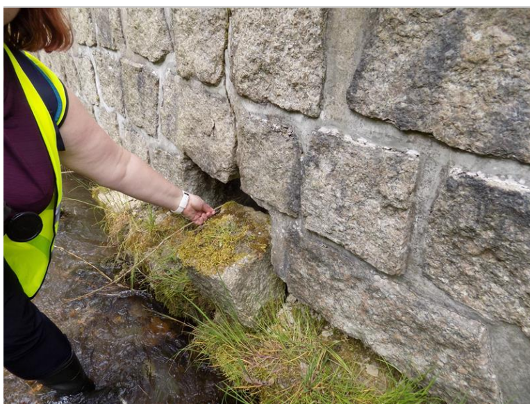
Dto - měření hloubky podezření zdi
