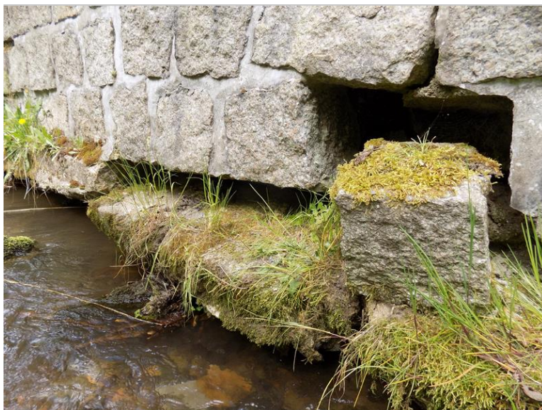
Vypadlé kameny z opěrné zdi na levé straně za opěrou OP2
