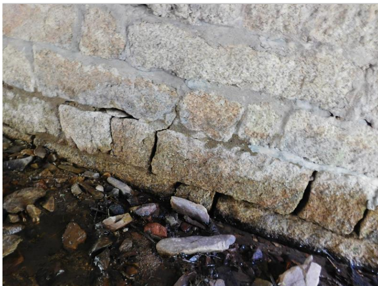
Rozvolnění zdiva díku opěry
